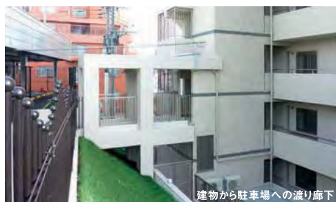
建物から駐車場への渡り廊下
