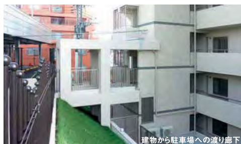
建物から駐車場への渡り廊下
